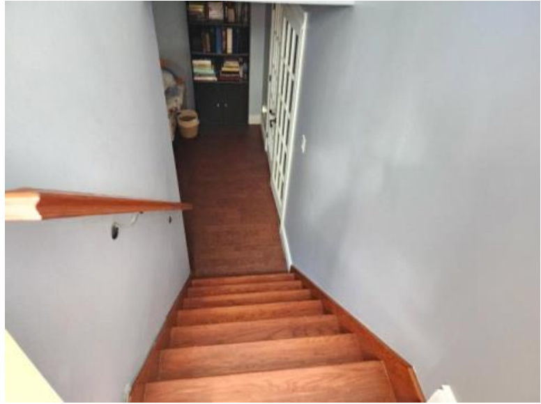
L'escalier donne accès au sous-sol. Bonne condition.
